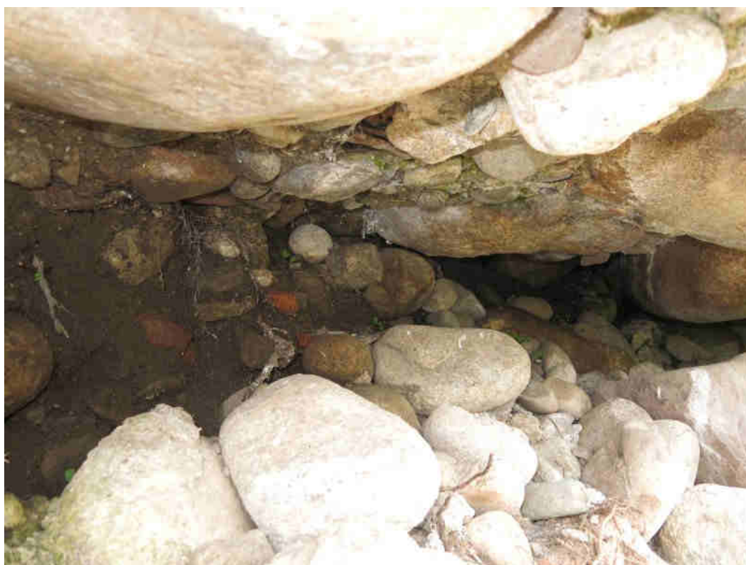
Foto 4: Kameny a balvany s hlínou na rubu betonové zdi (v kaverně)
