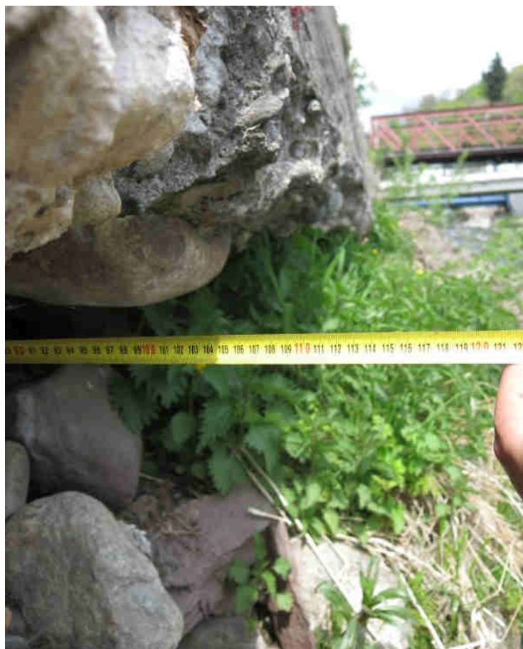
Foto 5: Hloubka kaverny v patě betonové zdi
