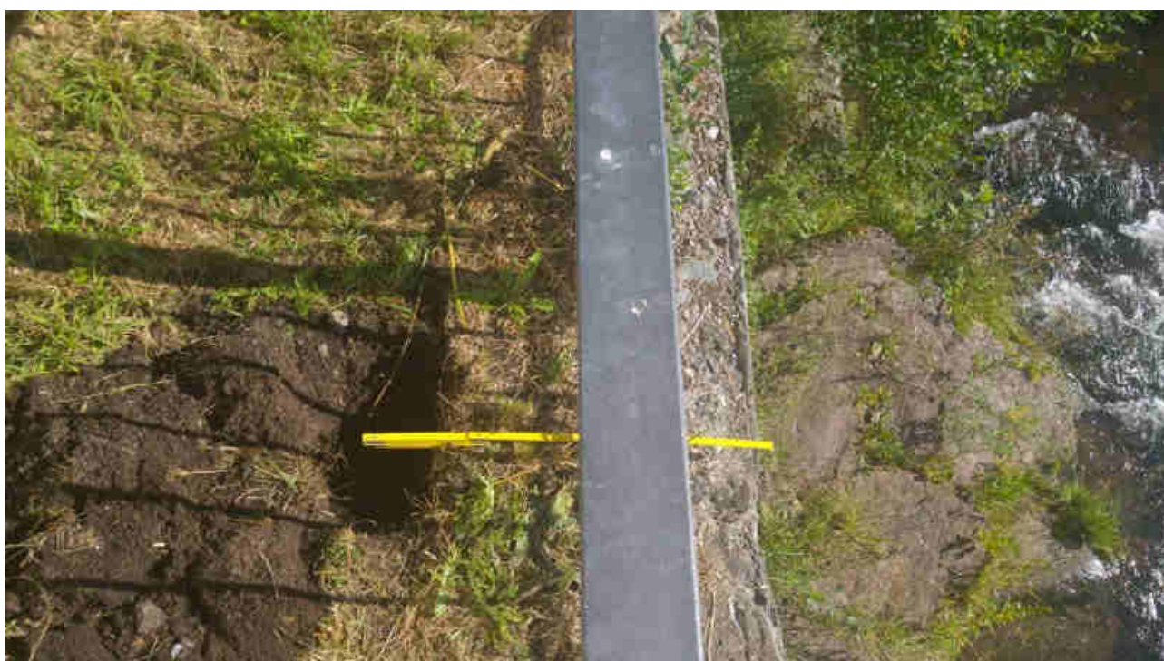
Foto 2: Ověření šířky koruny stávající betonové zdi
